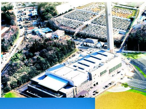
平成 17 年に完成した市内で最も新しい清掃工場。2 機の高機能的な炉が 3 ヶ月交替で 24 時間運転している。J R 常磐線を境に南側の可燃ゴミを処理している。炉の余熱を利用してリフレッシュプラザを併設。温水プールなどを備えた憩いのスペースを提供している。施設内には最初から見学用のコースや設備が整っており、ガイド専門のスタッフがいる。ゴミ収集車から直接巨大なゴミピットに投入される様子は圧巻。ゴミ収集日以外でも可燃ごみや布団などを直接持ち込むことが可能。ただし車載してゴミ投棄の前後の重量を計量し、重量に応じて料金が発生する。
